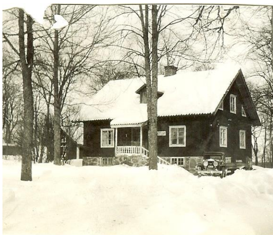
Inspektorsbostaden, även mejeri och lantbruksskola vid Ruda gård. Huset brann julafton 1946.
